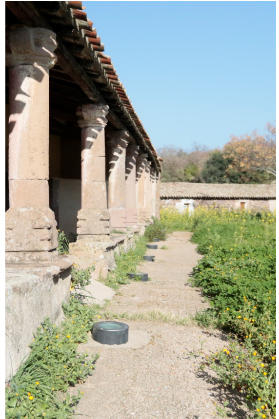
Fig. D-E, Particolare marciapiede già realizzato (a sinistra) e marciapiede con il solo massetto di cemento ed i corpi illuminanti predisposti alla quota di progetto finita del pavimento (a destra).
