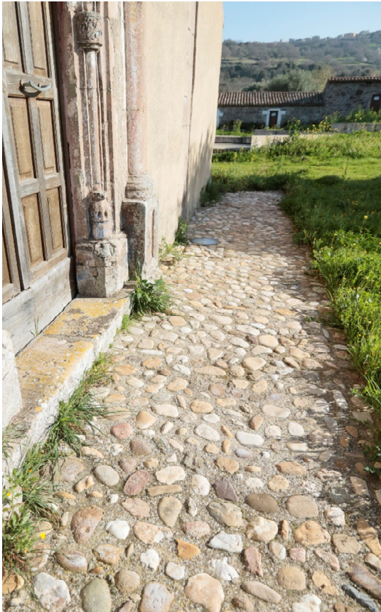
Fig. D-E, Particolare marciapiede già realizzato (a sinistra) e marciapiede con il solo massetto di cemento ed i corpi illuminanti predisposti alla quota di progetto finita del pavimento (a destra).
