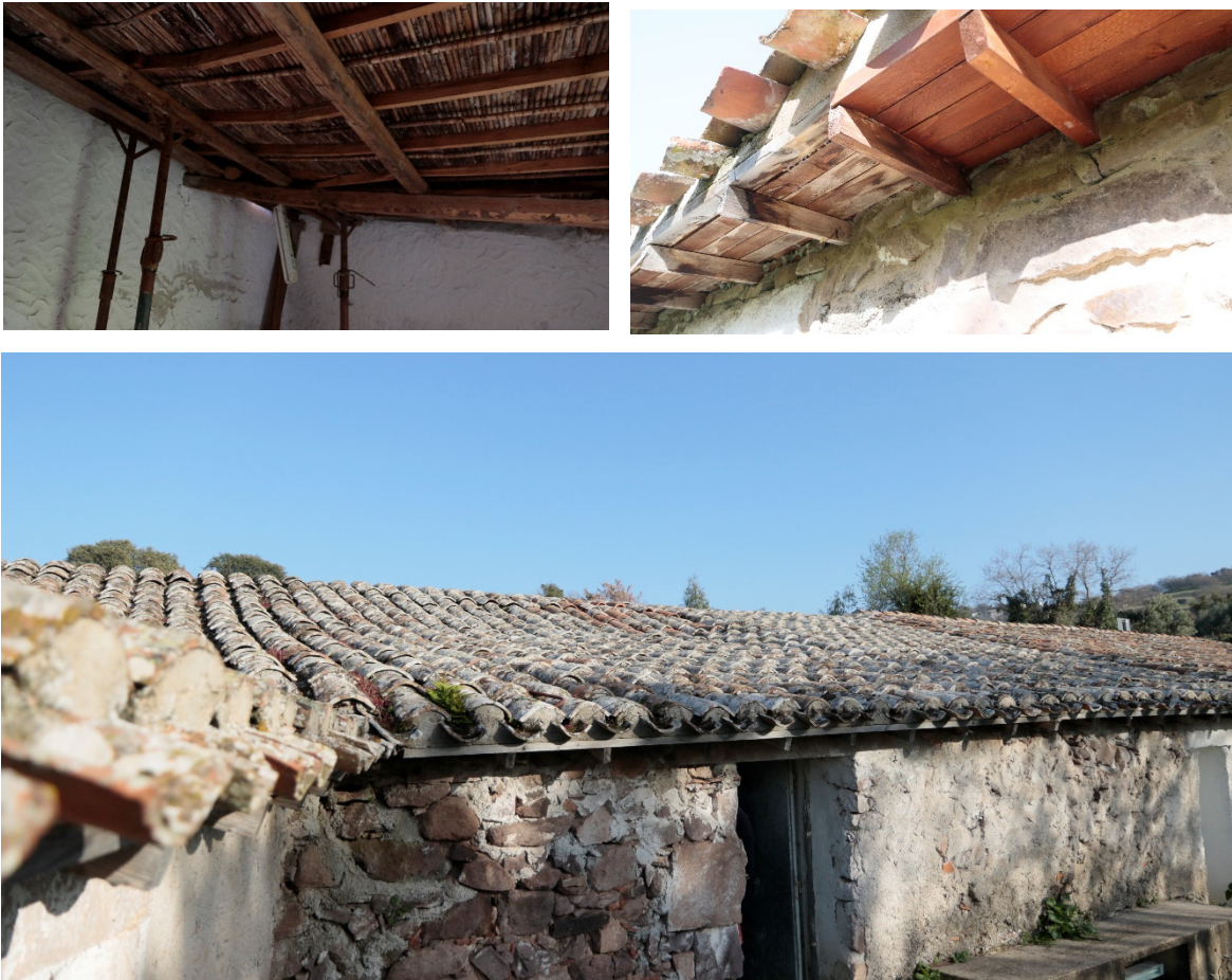
Fig. A-B-C, Particolare interno e facciata del Muristenes Silanus, oggetto d'intervento.
