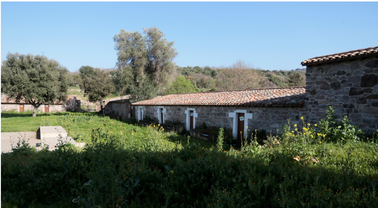
Fig. 6/7 – Vista dei muristenes già recentemente restaurati e posti nell'ala sud-est del complesso (sopra) e particolare del prospetto interno dei muristenes ancora da restaurare e posti nella parte nord-ovest del complesso (sotto).
