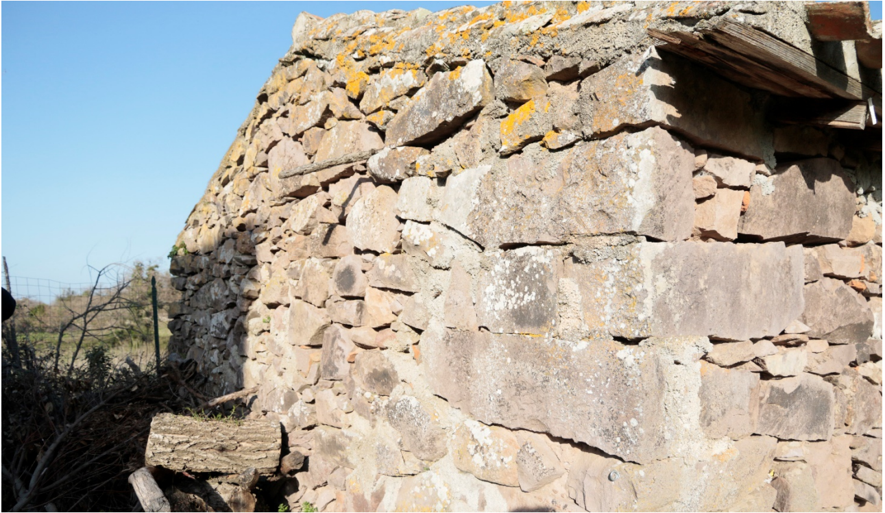
Fig. 12 – Particolare della muratura a sacco esistente, eseguita con conci irregolari di trachite locale.
