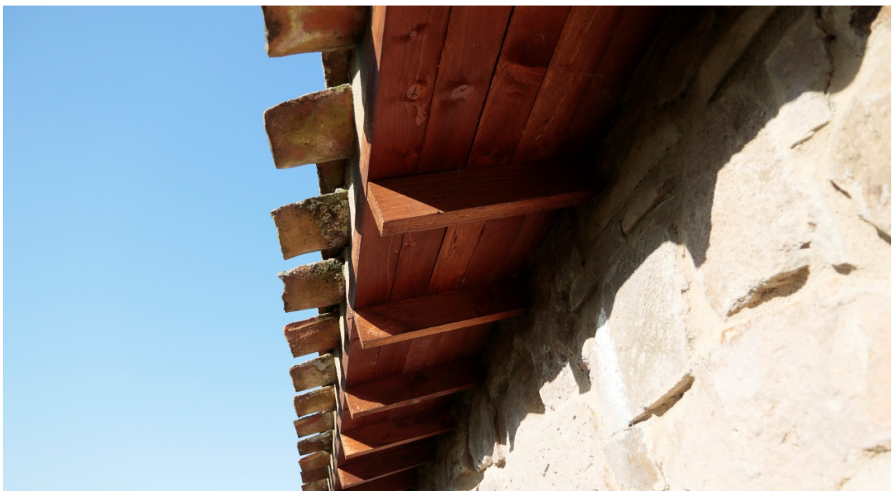
Fig. 9/10 – Particolari interni della copertura esistente con la cannucciato (sopra) e dello sporto della mantovana con la tipica tegola in aggetto (sotto).
